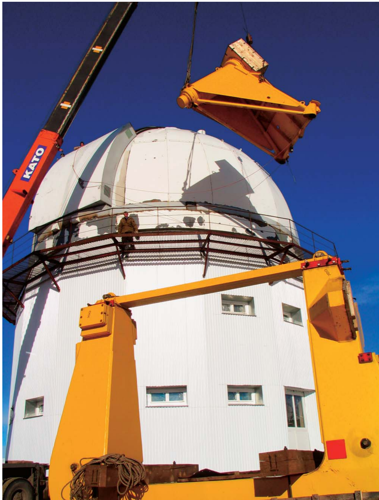
Монтаж инфракрасного телескопа АЗТ-33 ИК. Фото В. Короткоручко
