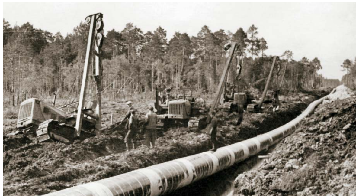
18 Строительство нефтепровода Шаим — Тюмень (1962—1963 гг.)
