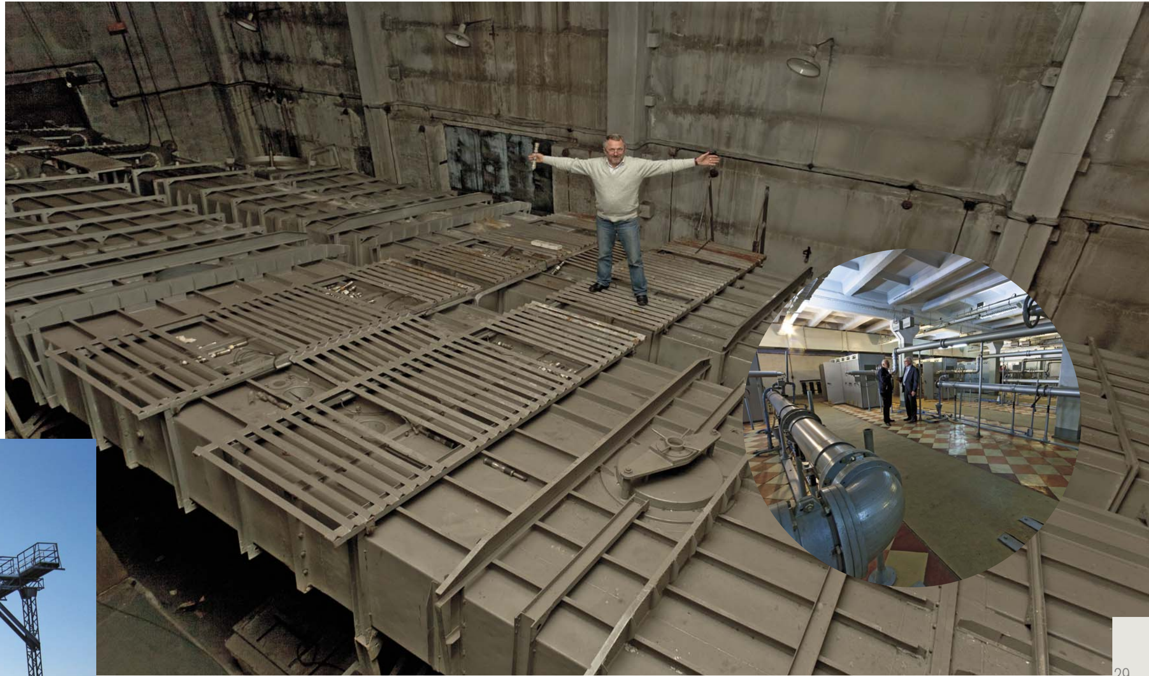
Размеры антенны Иркутского радара НР (слева) составляют 240 м в длину, 12 м в ширину и 20 м в высоту
