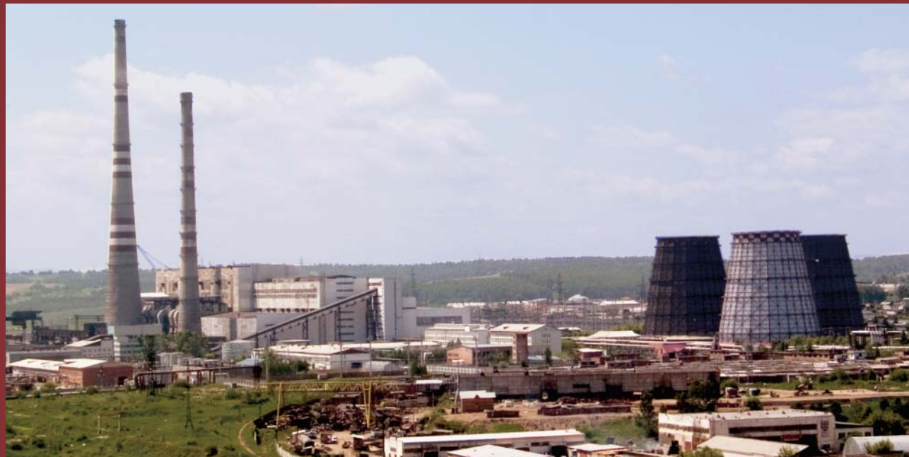
Новоуральская ТЭЦ. Фото В. Короткоручко
