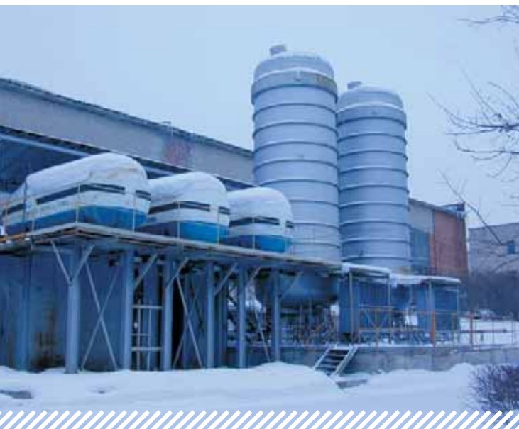
Внутренние внешние хранилища LKr-калориметра: в экспериментах на КЕДР используется огромное количество жидкого криптона — 27 тонн!
