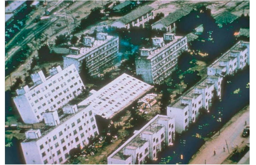
Землетрясение 16 июня 1964 г. в Ниигате, Япония. Вид с воздуха на дома, которые наклонились вследствие разжижения почвы и плохих фундаментов. Национальный центр геофизических данных
