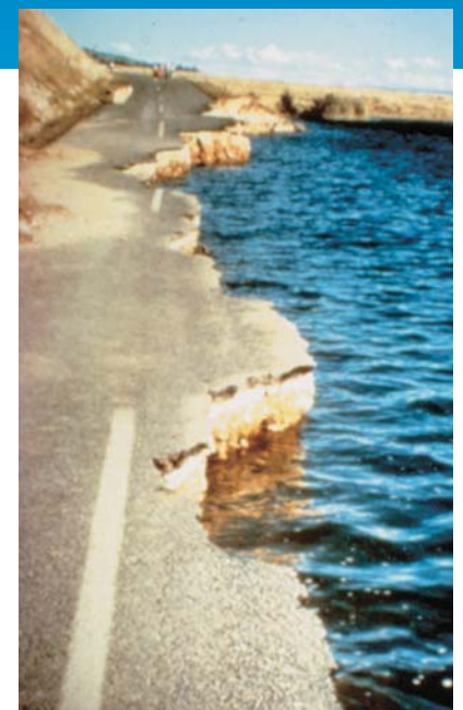
Во время землетрясения 18 августа 1959 г. участок шоссе 287 рухнул в озеро Хебген, Монтана (США). Оползни, затопление, появление трещин и смещение дорожного полотна сделали дорогу непроезжей на участке длиной в 58 км. Свыше 200 отдыхающих оказались в ловушке в Каньоне Мэдисон. Фото: из архива Калифорнийского университета (Беркли, США)
