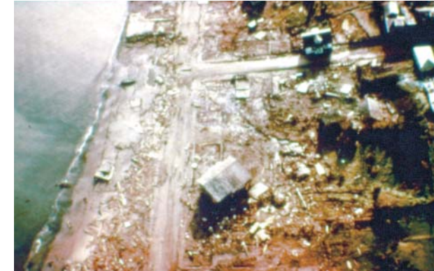
Ущерб от цунами, вызванного землетрясением 1946 г. вблизи Алеутских о-вов (Аляска) и обрушившегося на Гавайи, составил 26 млн дол. В г. Хило все дома, обращенные к заливу, были смыты, железные дороги разрушены, а прибрежные дороги уничтожены. Фото из архива инженерных войск США
